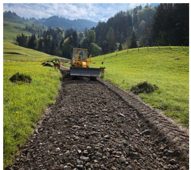
Aufbruch bestehender Strasse
