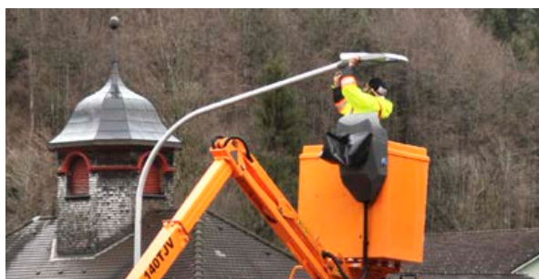
Ein neuer Leuchtenkopf wird installiert.
