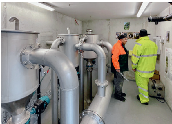
Reinigung Wasserreservoir: Heiri Mathis und Adi Burch
