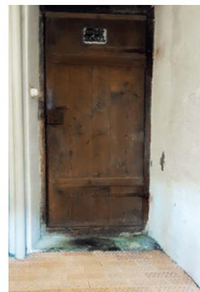
Neu eingelegter Kellerboden
