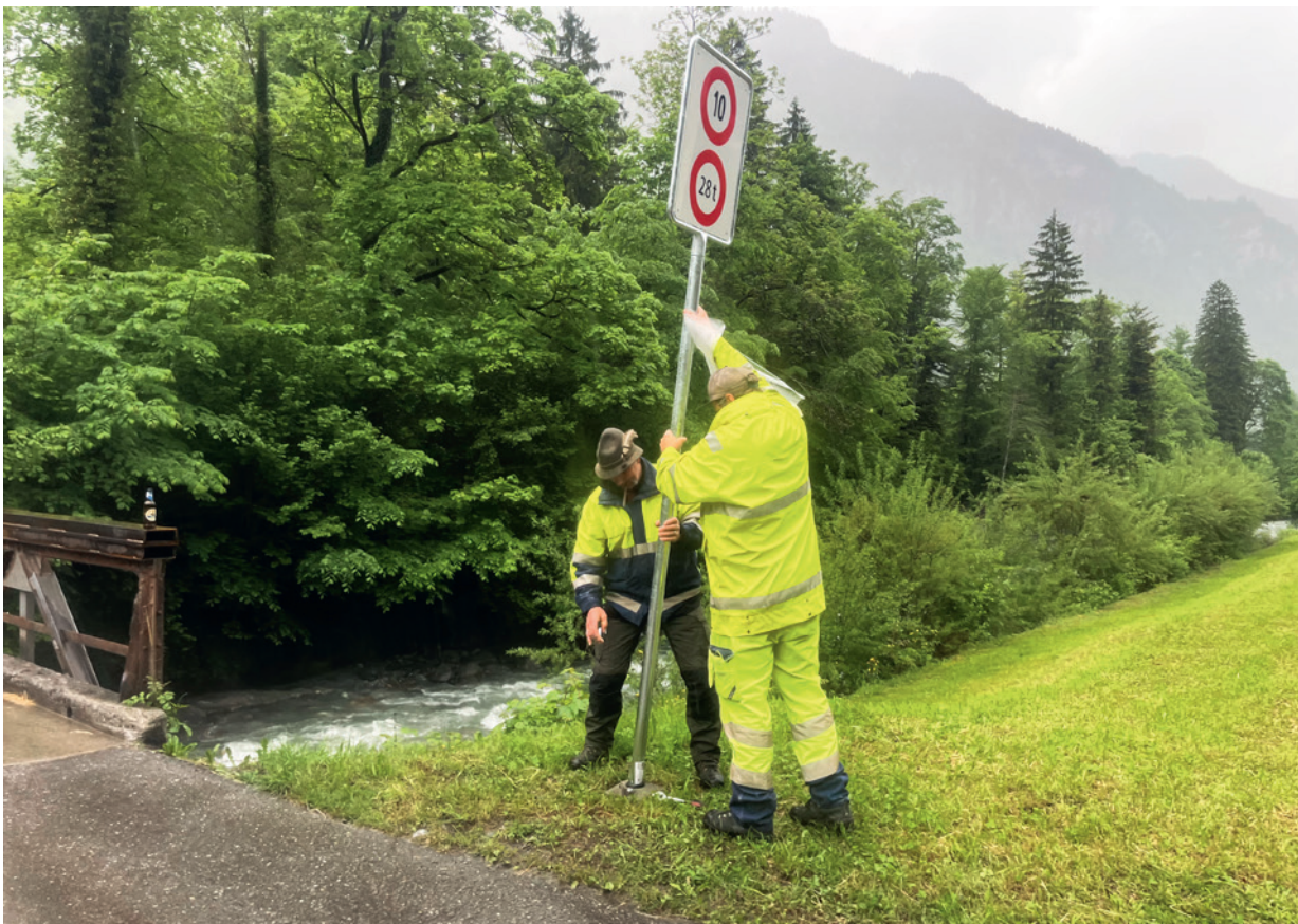
Adrian Burch und Sepp Niederberger beim Montieren des neuen Verkehrsschildes.
