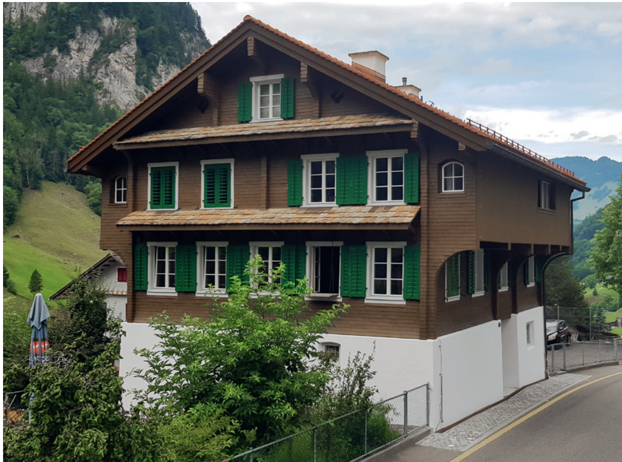
Alte Kaplanei nach der Renovation
