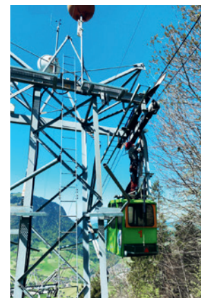
Servicearbeiten an der Bahn
